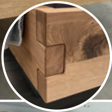
Eckverbindung ausgeklinkt
